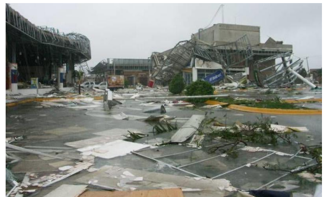
Foto: Daños del huracán Wilma, Cancún Q. Roo, Mexico (Oct/2005)
