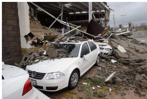
Foto cortesía EFE: Daños por Huracán Odile (Sept / 2014).
